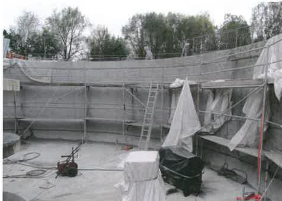
Abb. 3: Hellgraue, d.h. abgetrocknete, nicht nass nachbehandelte Spritzmörtelschicht
