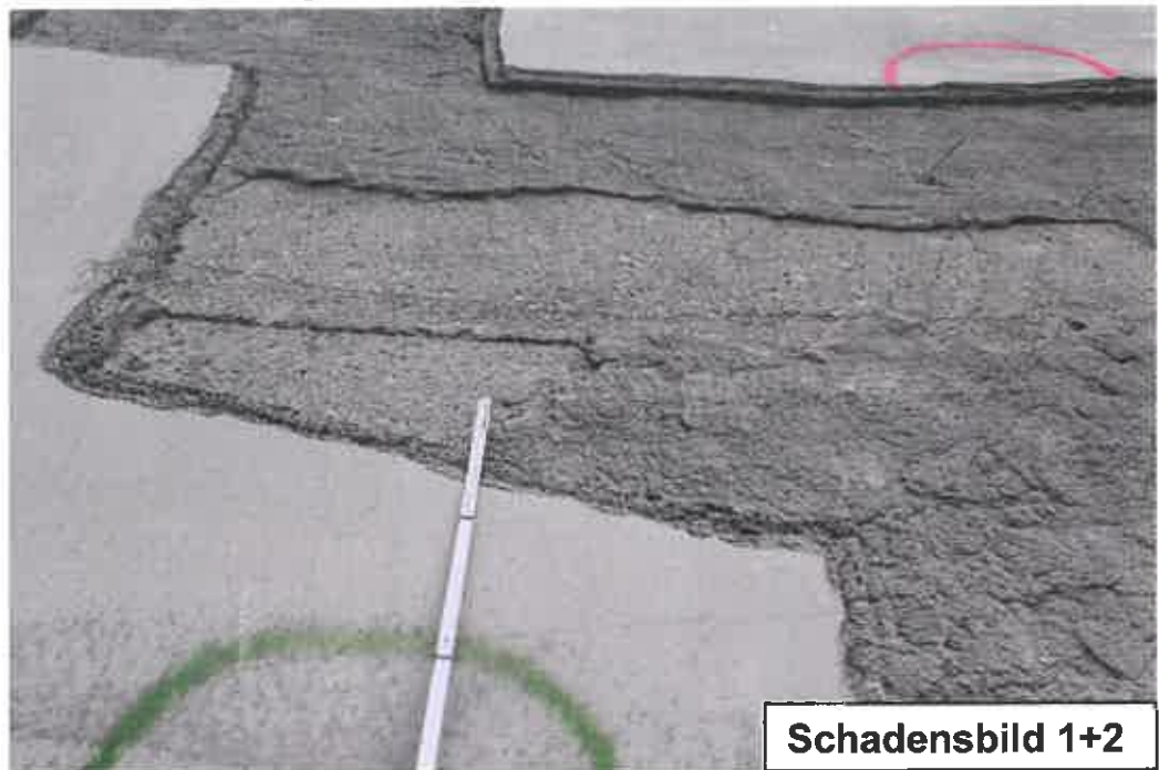
Abb. 7c: Unregelmäßiger Übergang der beiden Schadensbilder
