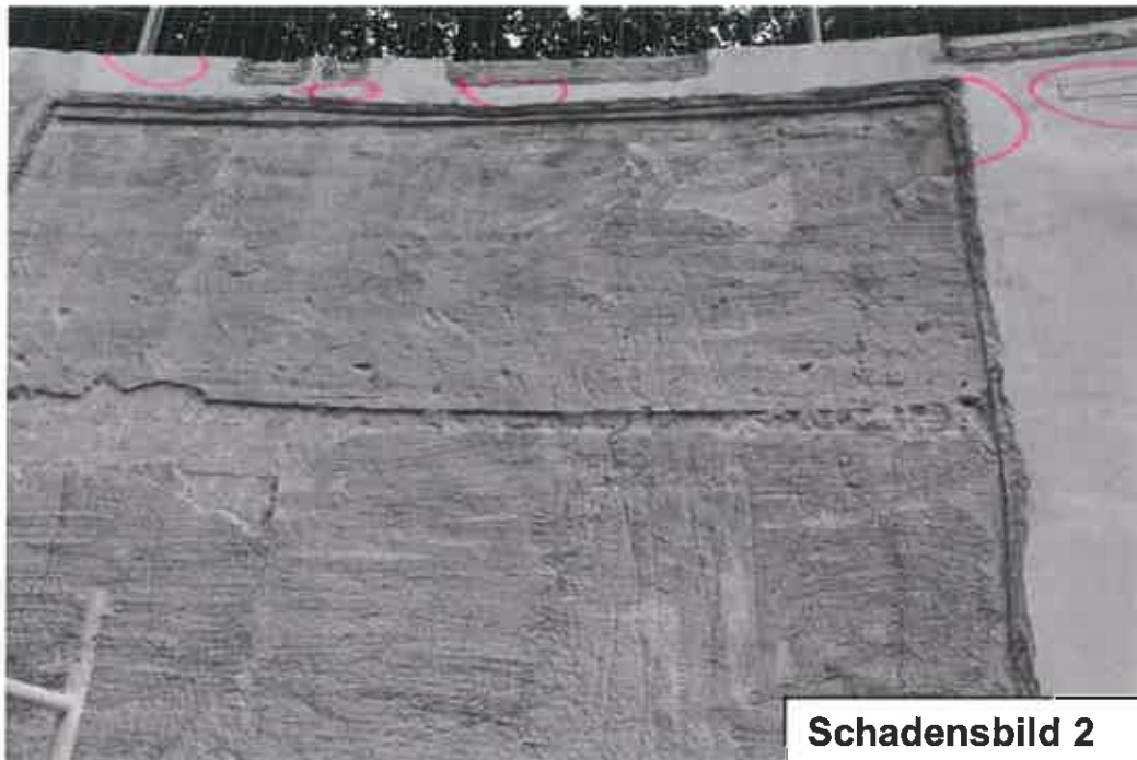
Abb. 7a: Trennlagenbildung zwischen 1. und 2. Spritzmörtellage, in dem horizontalen Streifen befand sich offensichtlich eine Leiste als Höhenlehre.
