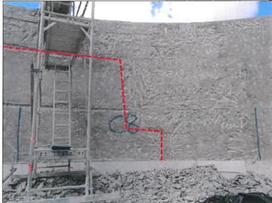
Foto 6: Übergang Bereich ohne (links) und mit Verbund (rechts)
