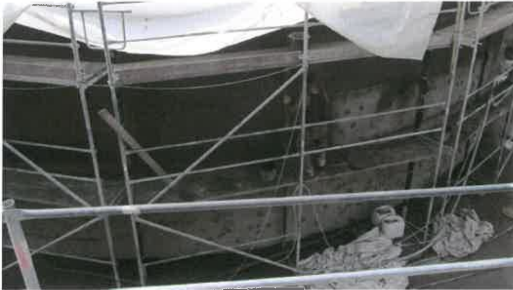
Foto 7: Spritzmörtelapplikation, gerüstlagenweise von oben nach unten.
