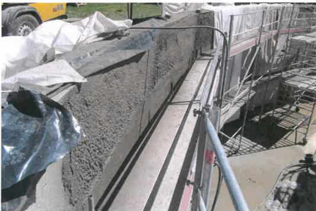
Foto 8: Spritzmörtelapplikation, gerüstlagenweise von unten nach oben
