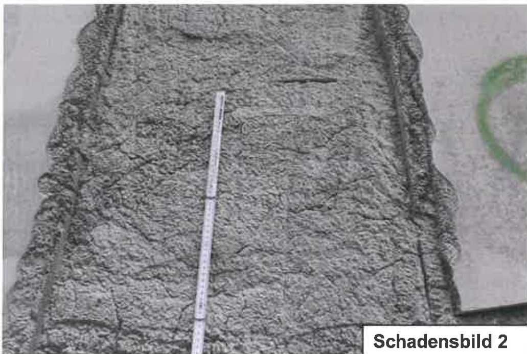
Abb. 7b: Nach Ablösung der 2. Spritzlage sind starke Rissbildungen in der 1. Spritzlage erkennbar.
