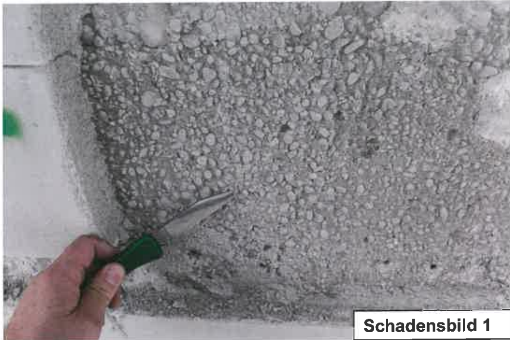
Abb. 6b: Intakte Zuschlagmatrix des Altbetons ohne Ausbildung von Bruchflächen
