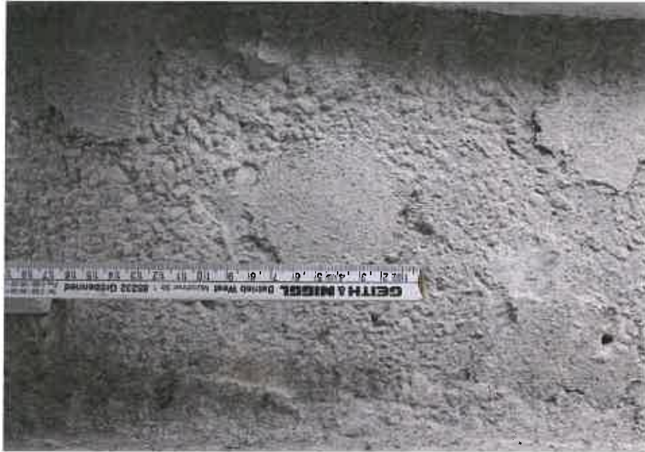
Foto 1: Hohllage in der Verbundfuge zu Bestandsbeton - Schadensbild 1
