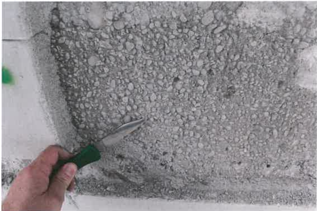
Foto 5: Hohllage ohne Bruchflchigkeit auf Altbeton
