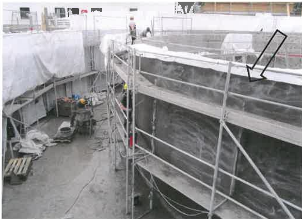
Abb. 2: Unsachgemäßer Auftrag des Nachbehandlungsmittels (Pfeil)
